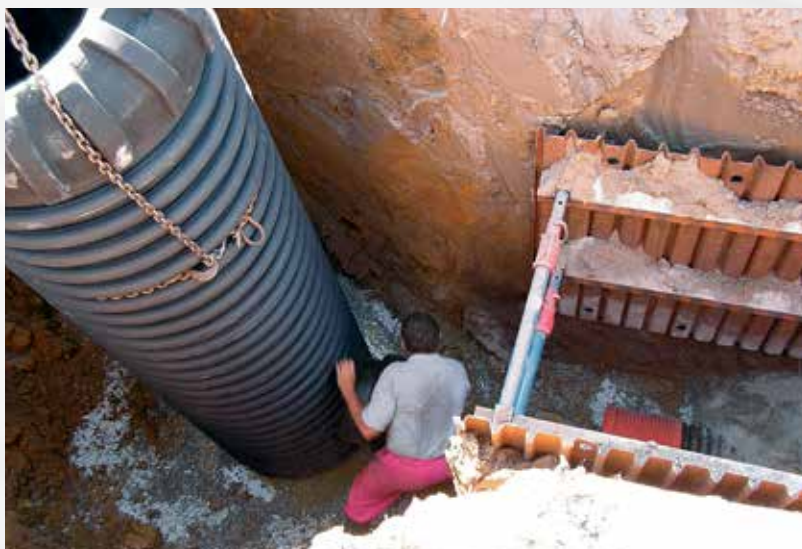
Šachta DN 1000 zakončená plastovým kónusem
