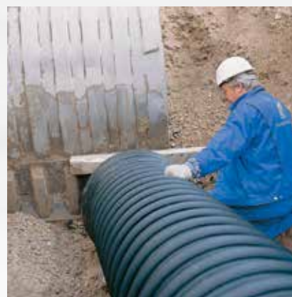
Spojování potrubí pomocí lžice bagru
