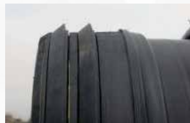
Spojování potrubí pomocí lžice bagru
