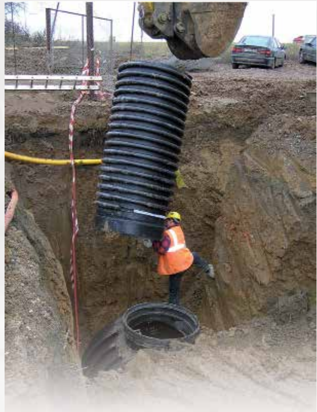
U větších hloubek je vstupní komín rozdělen a jeho montáž se provede až na stavbě pomocí hrdlového spoje.
