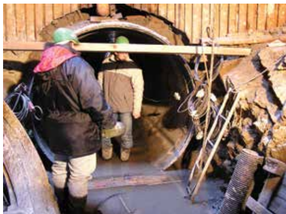
Uložení potrubí v ražené štole
