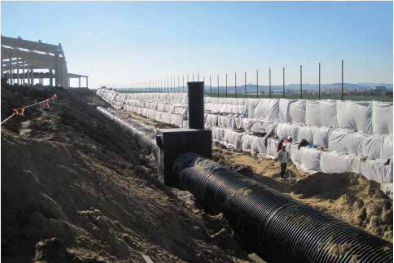
Retenční nádrž z potrubí DN 2000 se středovým výtokem opatřeným vírovým ventilem (dálnice R1 Nitra – Tekovské Nemce, Slovensko).
