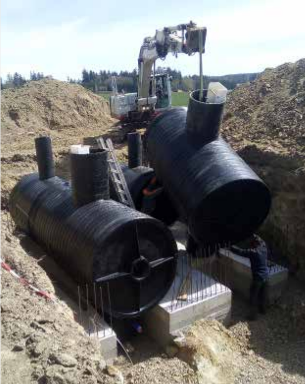
Betonový kotvící blok je nutný pouze při výskytu spodní vody
