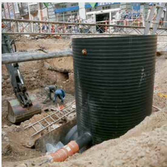
Šachta DN 2000, která bude zakončena železobetonovou deskou
