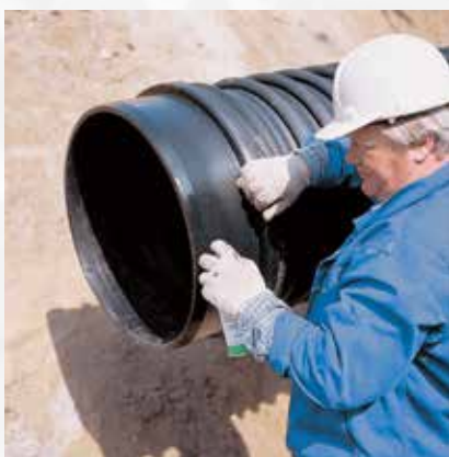
Nanášení maziva na hladký dřívek U určený do šachty
