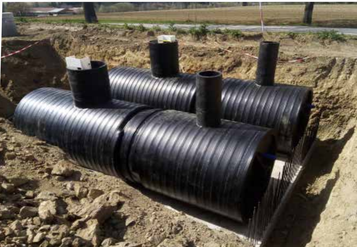
Nádrž s kapacitou 2x15m 3 ze dvou potrubí DN 1800 včetně vstupů a kalových jímek
