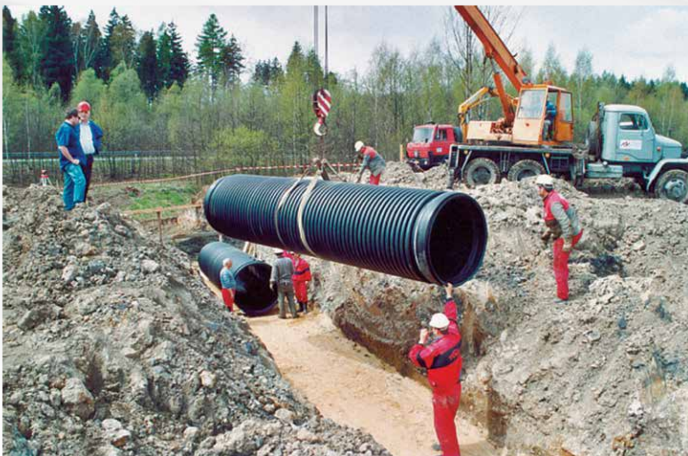
Potrubí se umísťuje do výkopu pomocí textilních třmenů
