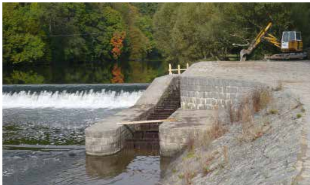
Celkový pohled na kartáčový rybí přechod na jezu Budín na řece Sázavě
