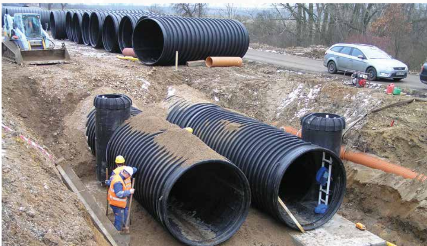
Retenční nádrž ze dvou potrubí DN 2000 s ruksakovými vstupními šachtami (dálnice R7, Bítovceves – Vysočany).
