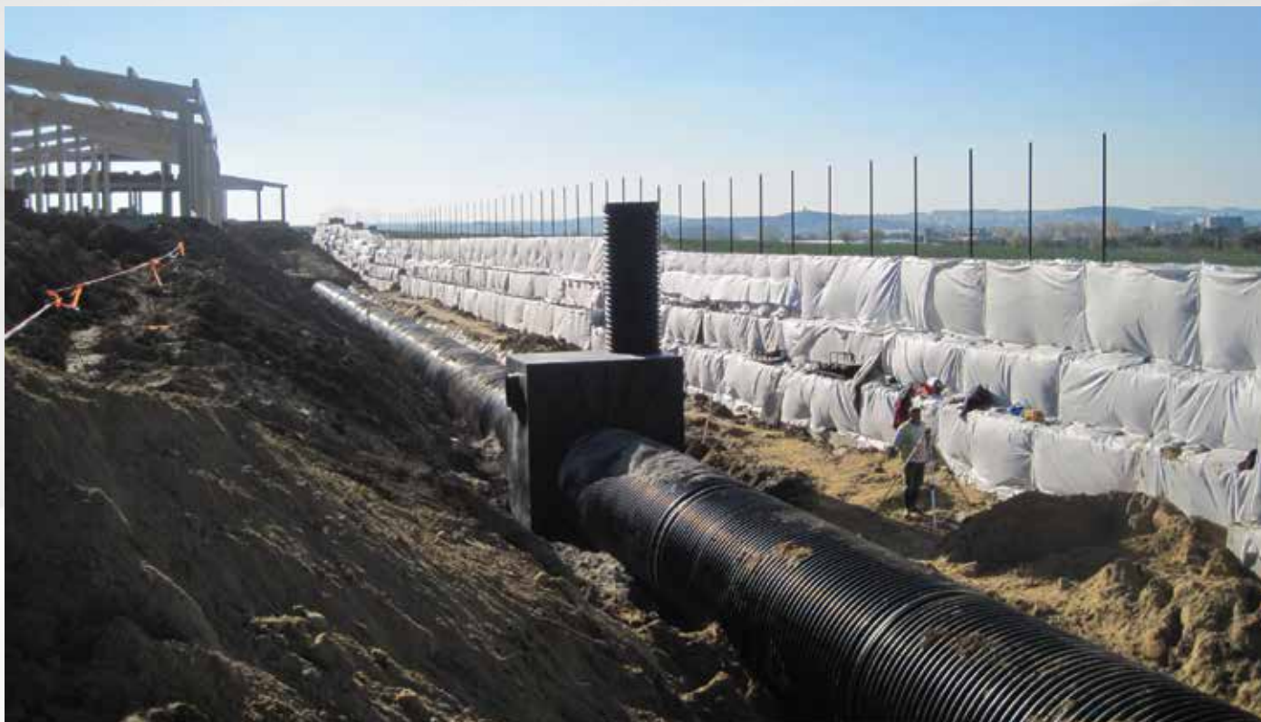
Retenční nádrž z potrubí DN 2000 se středovým výtokem opatřeným vírovým ventilem (dálnice R1 Nitra – Tekovské Nemce, Slovensko).
