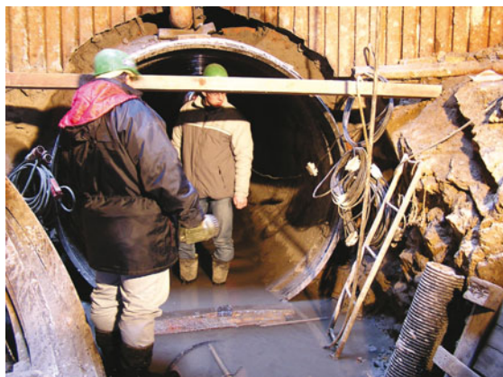
Uložení potrubí v ražené štole
