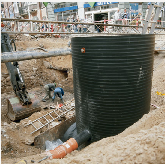
Šachta DN 2000, která bude zakončena železobetonovou deskou
