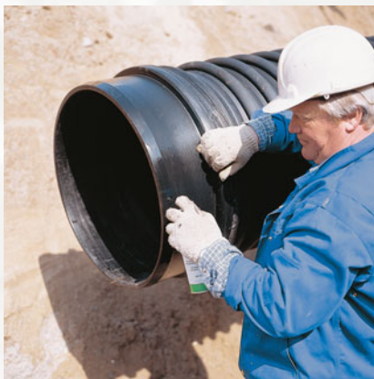
Nanášení maziva na hladký dřík U určený do šachty
