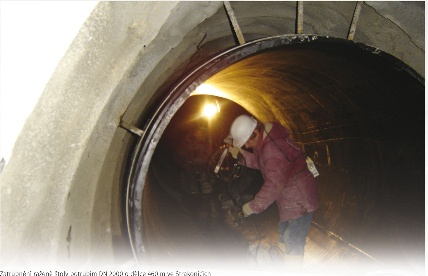
Zatrubnění ražené štoly potrubím DN 2000 o délce 460 m ve Strakonících
