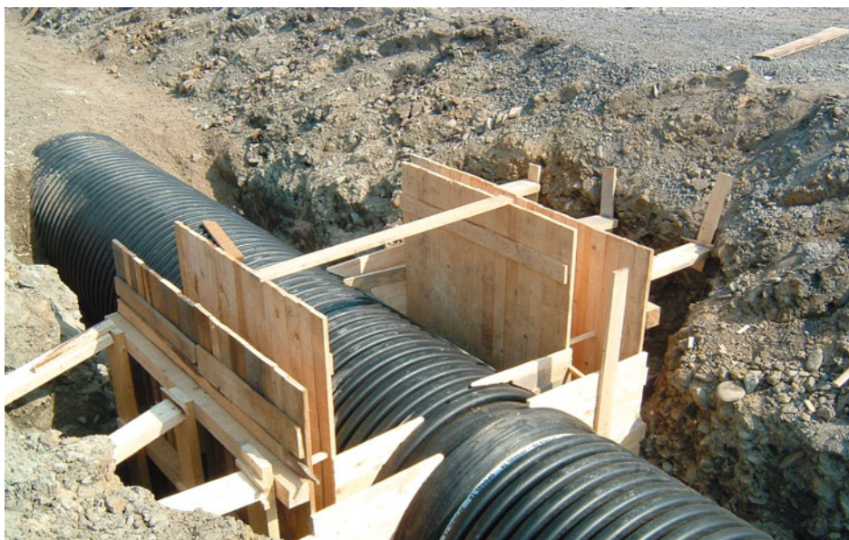
Bednění kolem potrubí pro výrobu monolitického dna šachty
