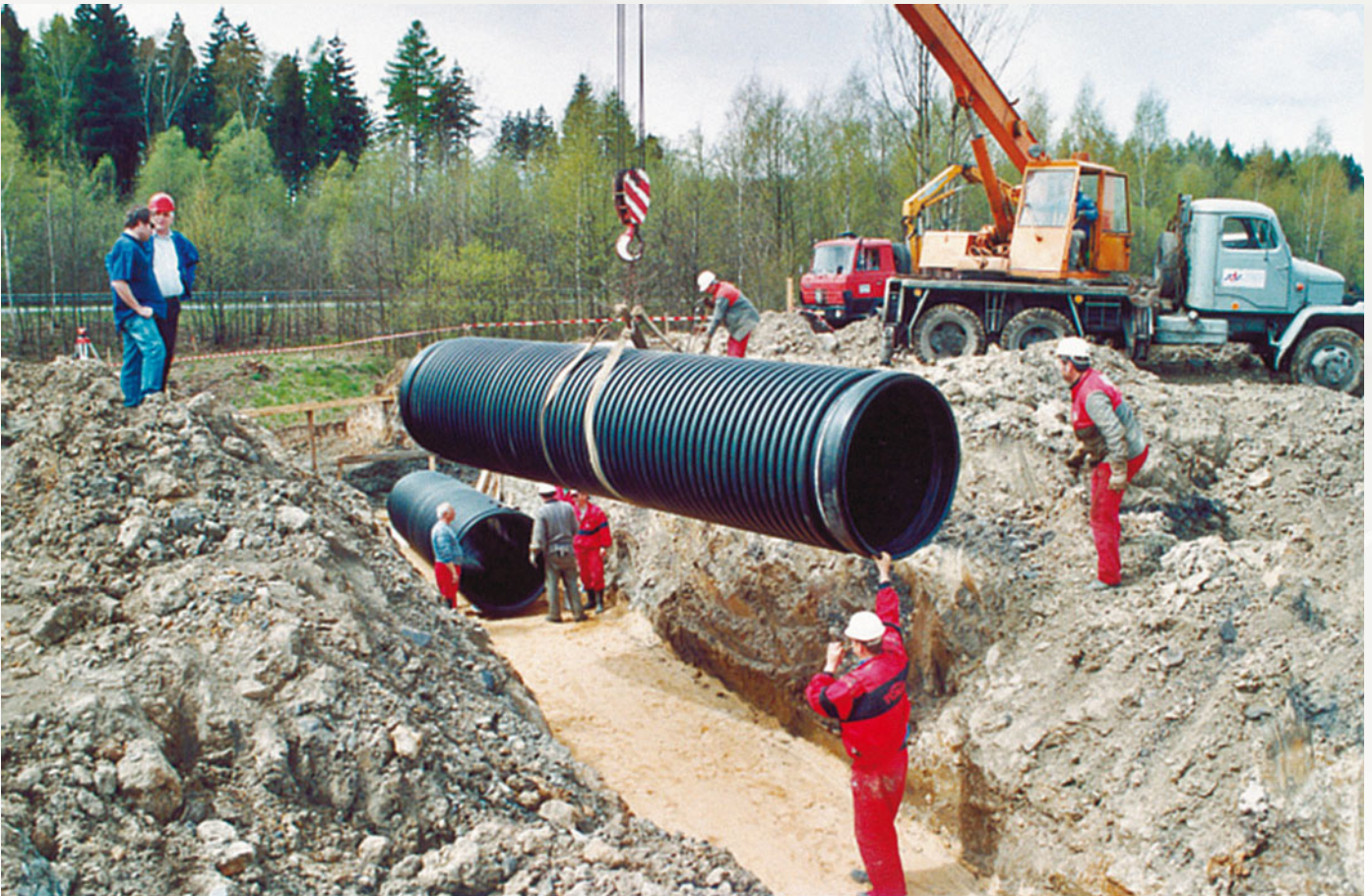
Potrubí se umísťuje do výkopu pomocí textilních třmenů
