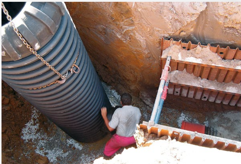
Šachta DN 1000 zakončená plastovým kónusem
