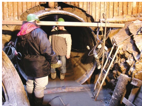
Uložení potrubí v ražené štolě
