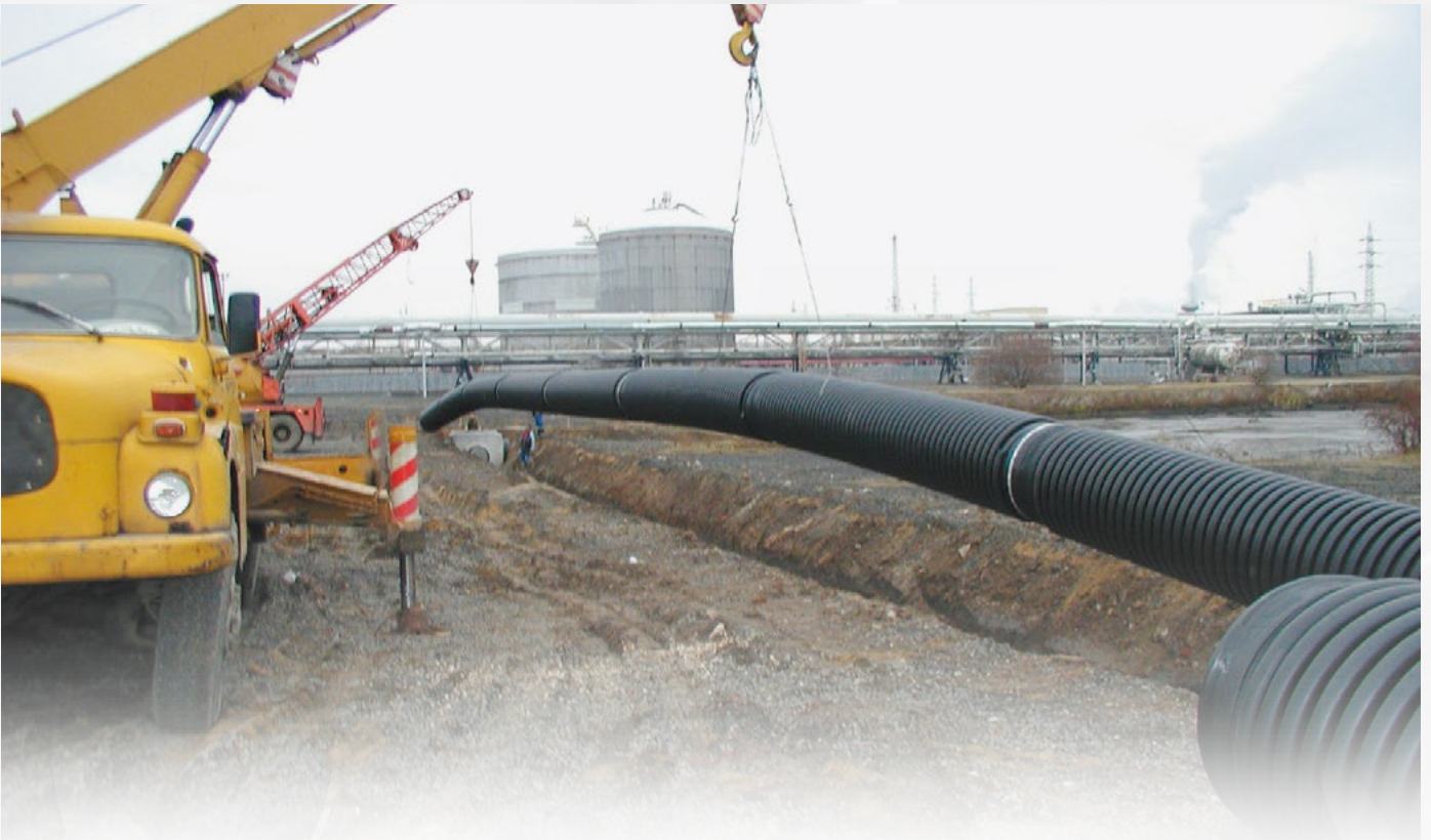
Instalace potrubí DN 1000, svařeného na tupo, do výkopu v poddolovaném území u Litvínova. Původně navrhované tlakové potrubí bylo zaměněno za potrubí Uporol speciálně vyrobené se dvěma dřívky na obou koncích. Tato varianta výrazně uspořila investiční náklady.
