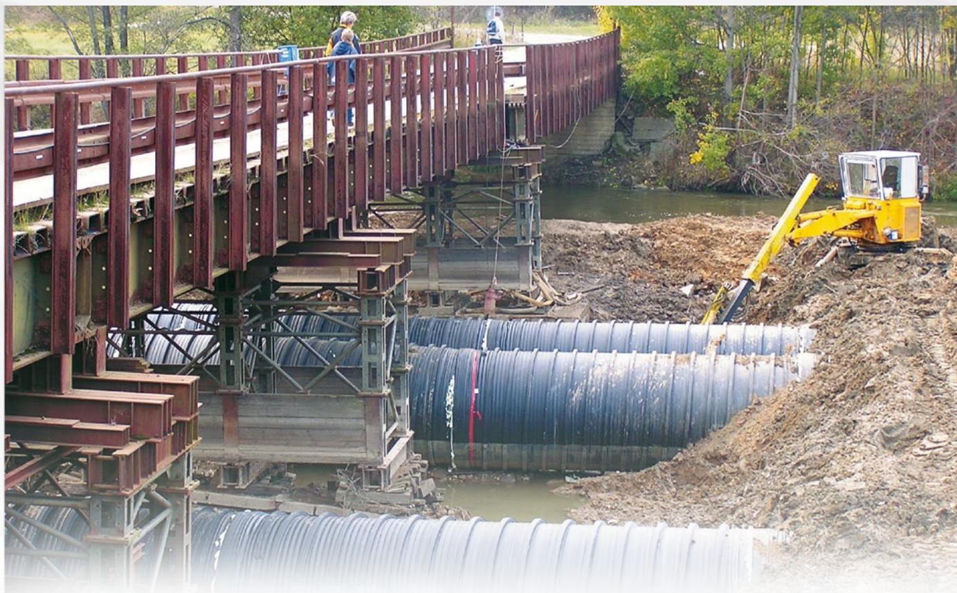
Tři shyby o délce 42 m z potrubí DN 2000 převáděly dočasně tok řeky Lužnice při opravě mostu v Sezimově Ústí.
