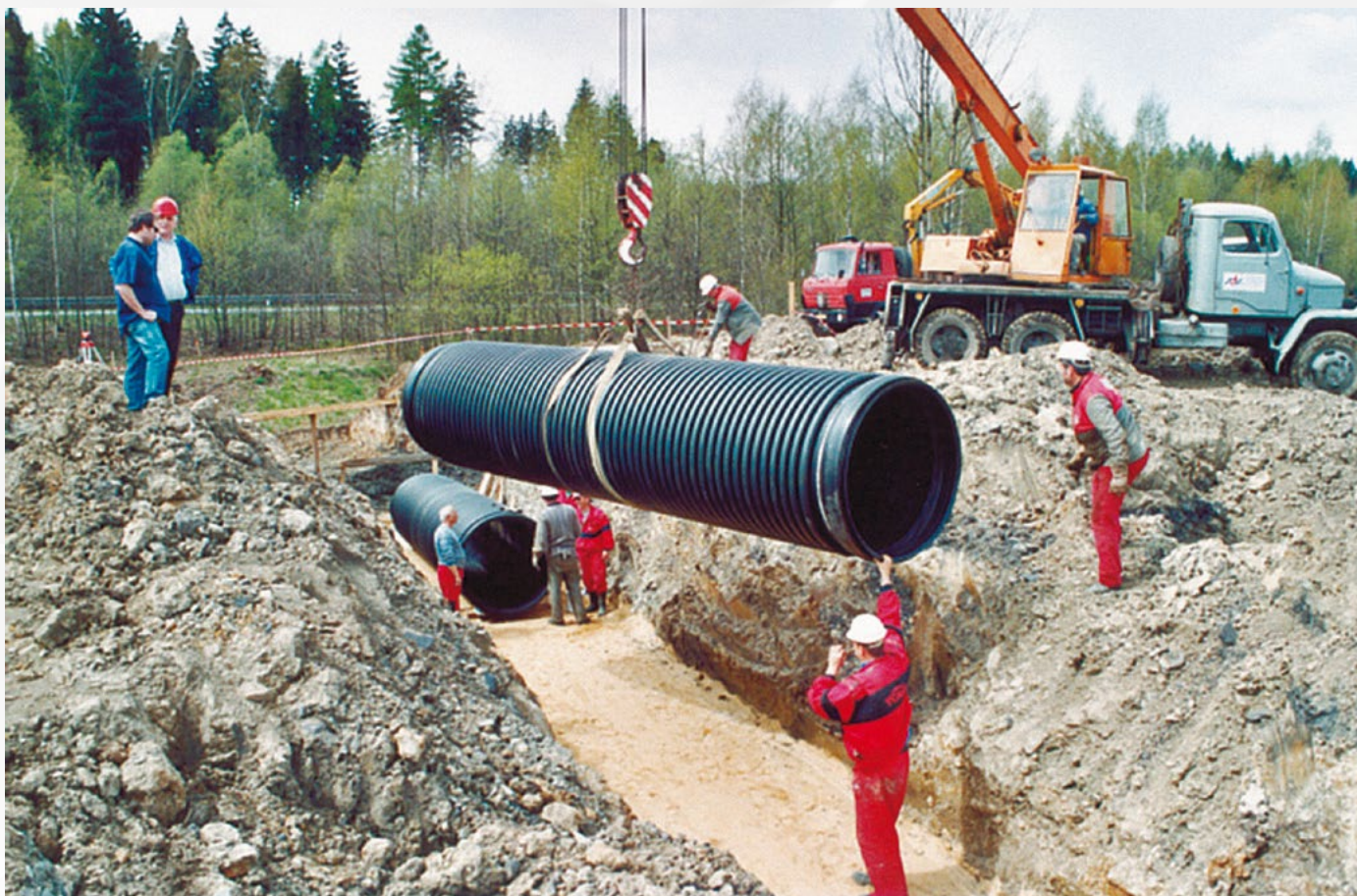
Potrubí se umisťuje do výkopu pomocí textilních třmenů
