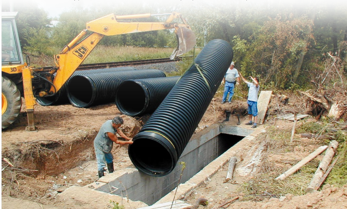
Rekonstrukce obdélníkové stoky potrubím DN 900 a 1000 bez nutnosti rozkopání povrchu v elektrárně Opatovice.
