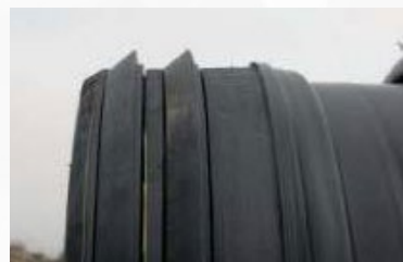
Spojování potrubí pomocí lžíce bagru
