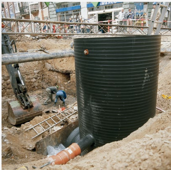
Šachta DN 2000, která bude zakončena železobetonovou deskou
