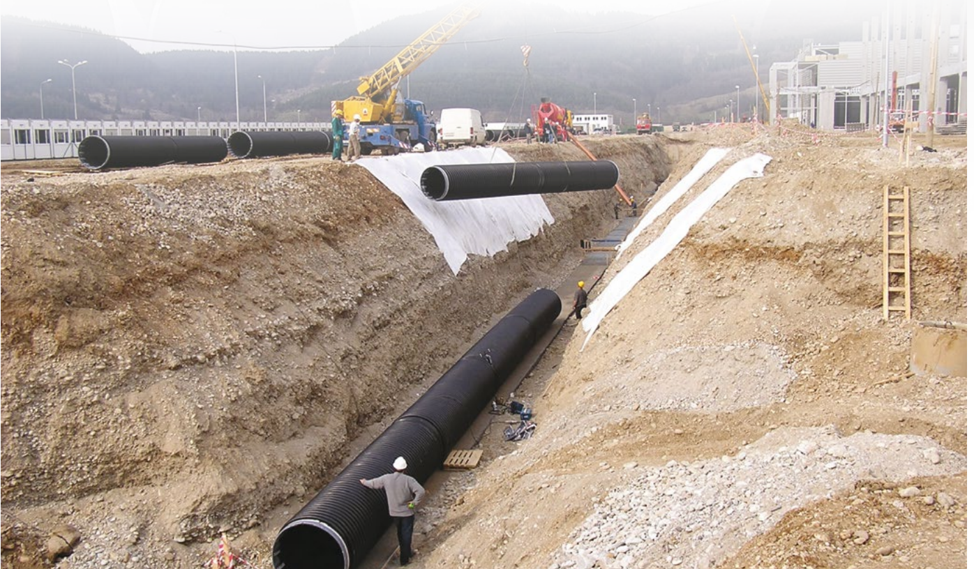
Potrubí DN 1200 na stavbě automobilky KIA na Slovensku s integrovaným elektrosvařovacím spojem v hrdle potrubí.
