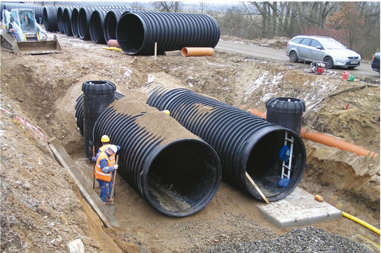
Retenční nádrž ze dvou potrubí DN 2000 s ruksakovými vstupními šachtami (dálnice R7, Bítovceves – Vysočany).
