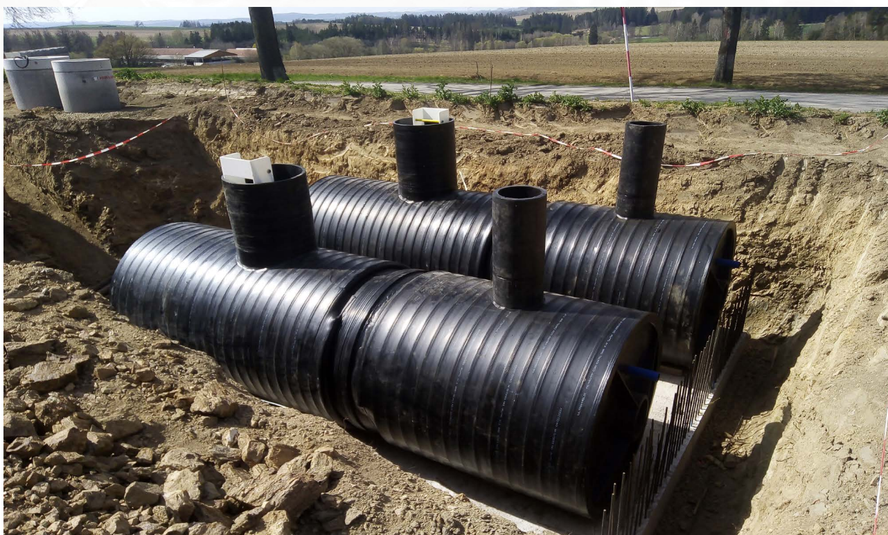
Nádrž s kapacitou 2x15m 3 ze dvou potrubí DN 1800 včetně vstupů a kalových jímek
