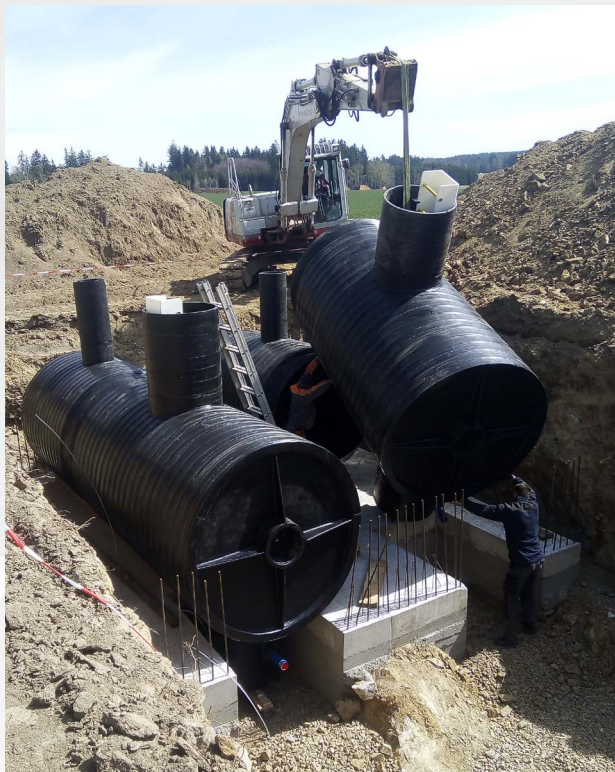
Betonový kotvicí blok je nutný pouze při výskytu spodní vody
