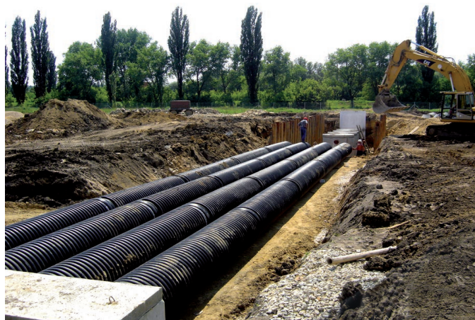
Retence vytvořena z několika potrubí Uporol o dimenzi DN 800 z důvodu nedostatečného krytí (areál firmy Sony v Nitře, Slovensko).
