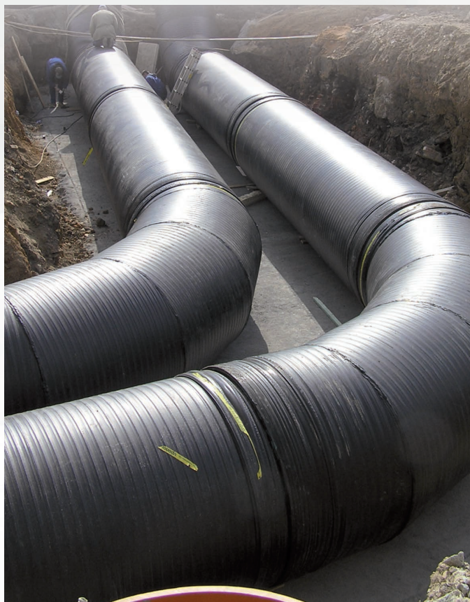
K potrubí Ultra Helix vyrábíme neomezený sortiment příslušenství vyráběný na míru. Z tohoto důvodu je možné se přizpůsobit různým technickým požadavkům, velikosti a tvaru pozemku.
