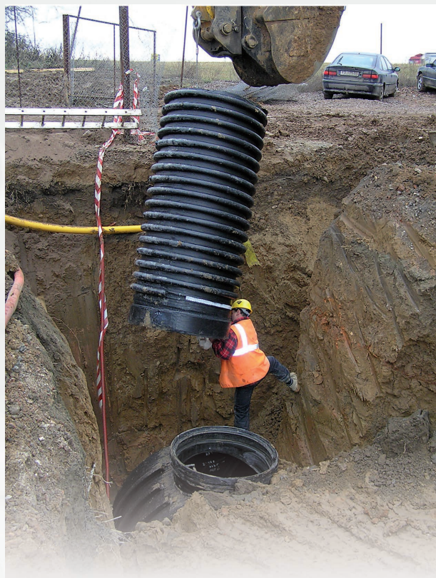
U větších hloubek je vstupní komín rozdělen a jeho montáž se provede až na stavbě pomocí hrdlového spoje.
