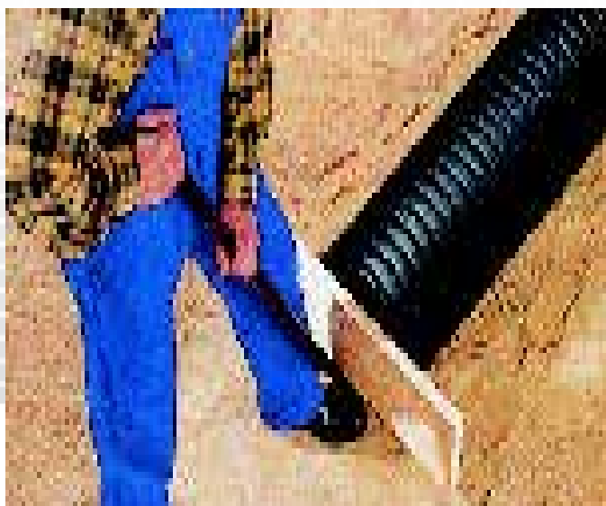
Pro spojení trub doporučujeme použít páčidlo opřené o kus prkna nebo trámku.
