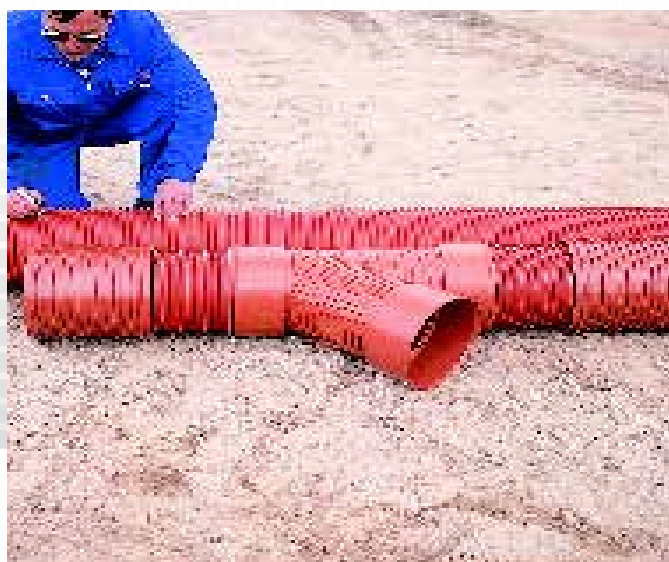
Odbočky, které se montují na již existující vedení, je třeba napřed smontovat s 2 kusy potrubí s přesuvnými objímkami. Délka se vyznačí na existující vedení. Vedení se vyřízne a nová odbočka se vsadí do vyříznuté mezery. Napojení na stávající vedení se provede přesunutím přesuvných objímek.
