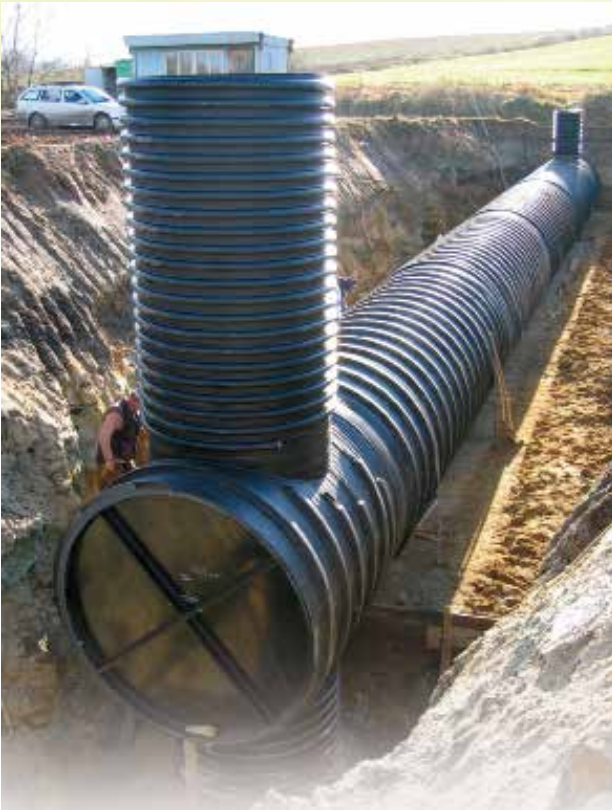
U přečerpávacích nádrží je pro čerpadla vytvořena na dně kalová jímka.
