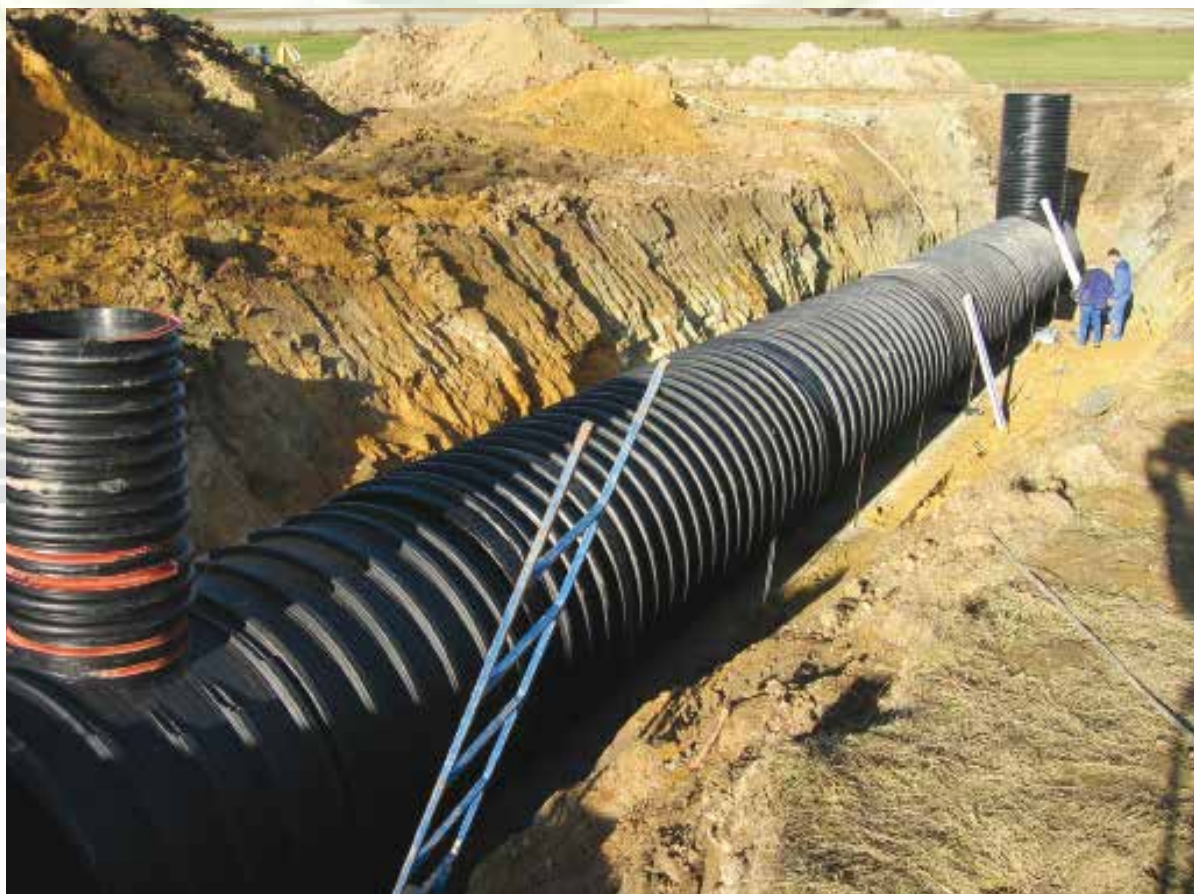
Přečerpávací nádrž z potrubí DN 2000 a kotvením na betonovou desku z důvodu vysoké hladiny spodní vody a malého krytí (průmyslová zóna Domažlice).
