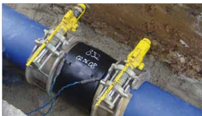
Obr. : Zakružovací svěrky pro elektrotvarovku (Zdroj: +GF+)
