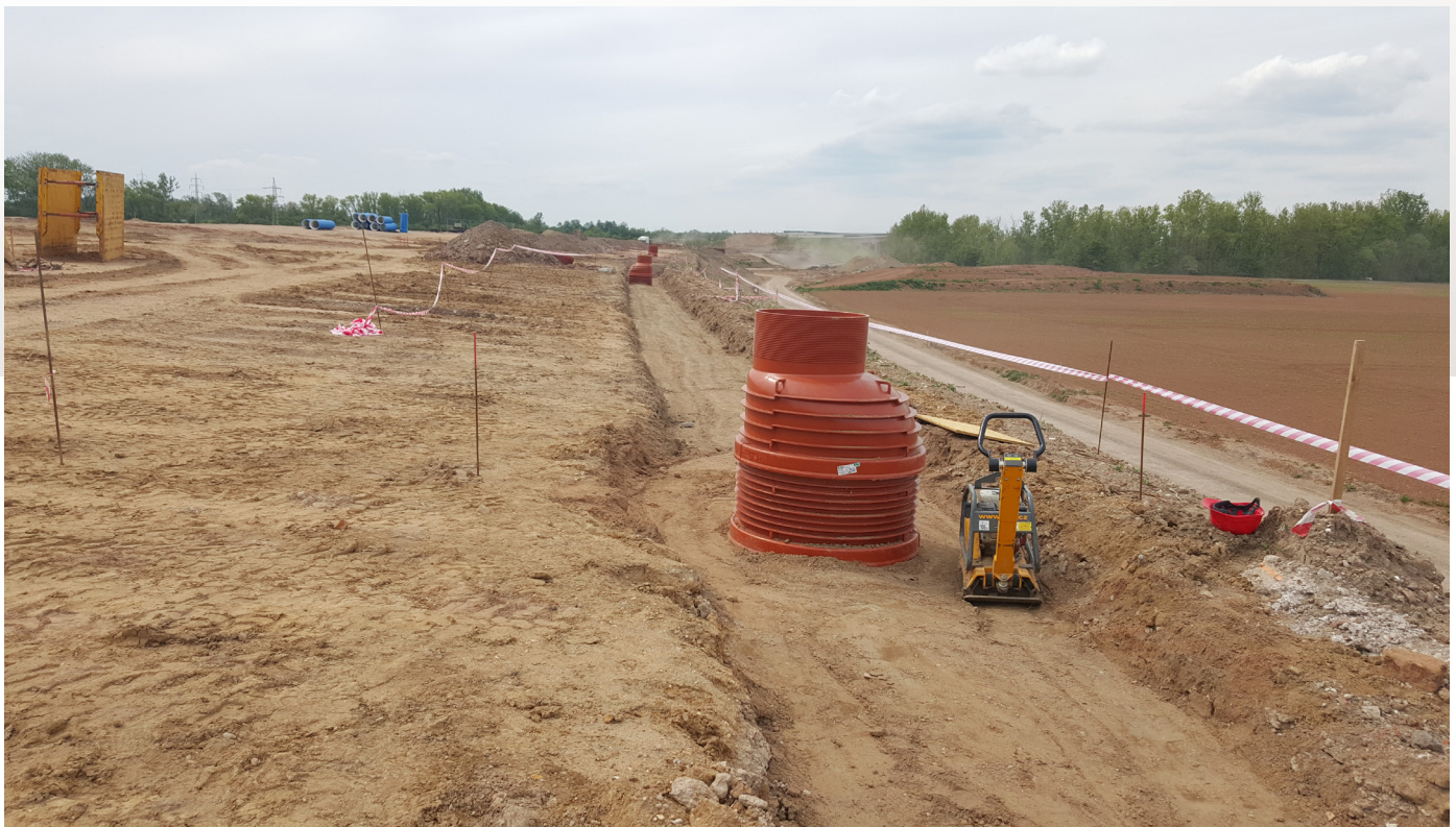
Dálnice D35 Opatovice - Časy
